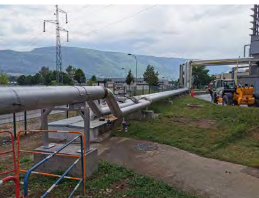
1. Création d'un nouveau réseau d'eau surchauffée
