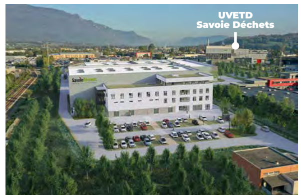
Insertion paysagère de la face Sud du site, avec l'UVETD en arrière-plan
