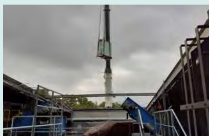
Ouverture de la toiture
