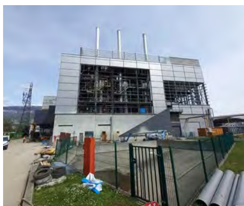
Phase de travaux (ouverture de la façade)
