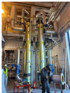
3. Mise en place des nouveaux échangeurs
